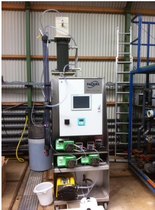
FIGUUR 2-1; FOTO VAN DE PILOT MET SULFAAT REDUCEREND SLIB IN DE PILOTHAL VAN RWZI HARNASCHPOLDER.
